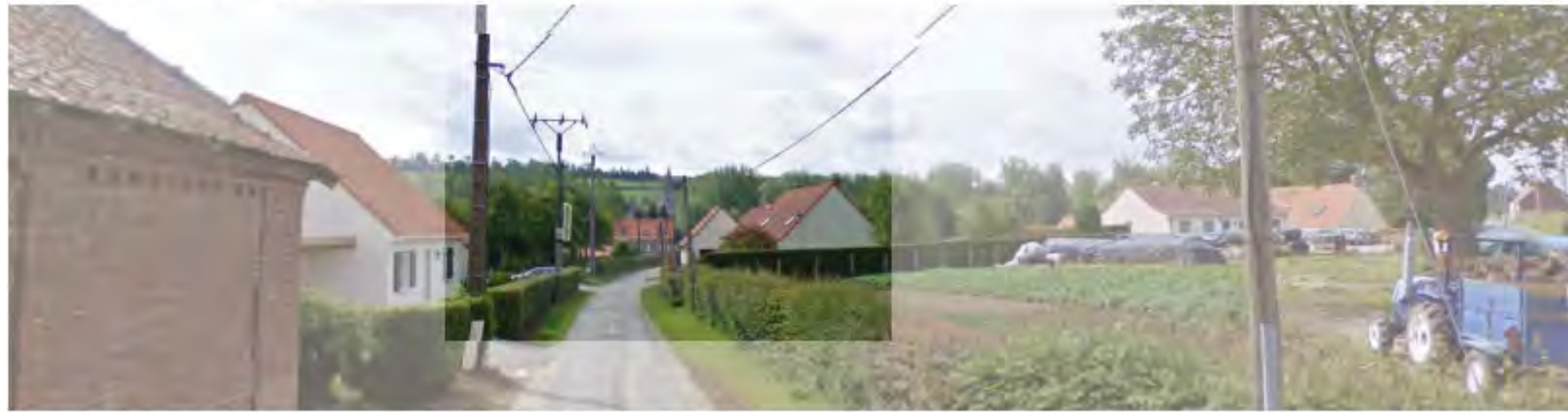
Illustration depuis la RD 225 dans la traversée de Merck St Lievin, au travers de l'une des fenêtre visuelle dans l'urbanisation et axée vers le plateau d'implantation et l'église classée aux monuments historiques
